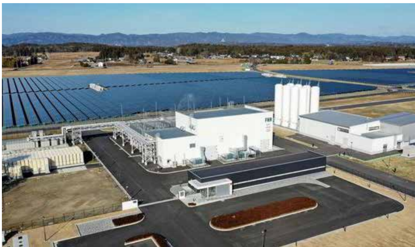
De grootste bestaande elektrolyse-installatie ter wereld staat momenteel in Japan en heeft een vermogen van 20 MW, overeenkomend met minder dan 8 windturbines. Hier is hij gekoppeld aan een zonnecentrale. De kostbare installatie wordt in deeltijd gebruikt voor het maken van waterstofgas.
