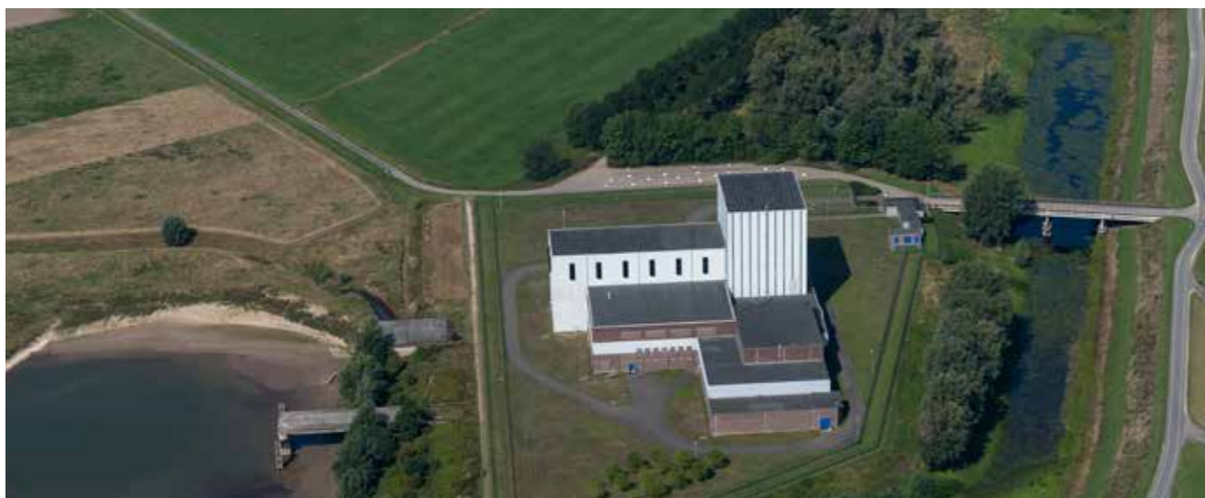
De experimentele kerncentrale in Dodewaard in de naburige regio was bijna 30 jaar in bedrijf en sloot in 1997. Met 58 MW vermogen was het een zeer kleine centrale, goed voor 0,5 TWh betrouwbare energie per jaar.
