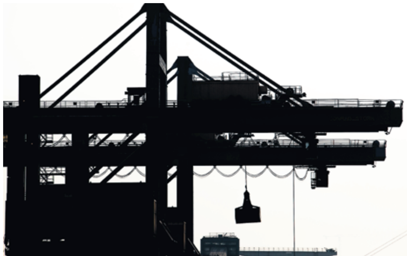
Kranen bij de Electrabel centrale in Nijmegen, waar kolen gelost worden uit schepen als brandstof voor de opwekking van elektriciteit.
